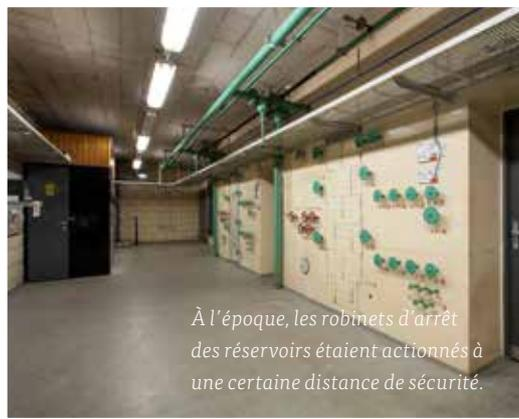
À l'époque, les robinets d'arrêt des réservoirs étaient actionnés à une certaine distance de sécurité.
