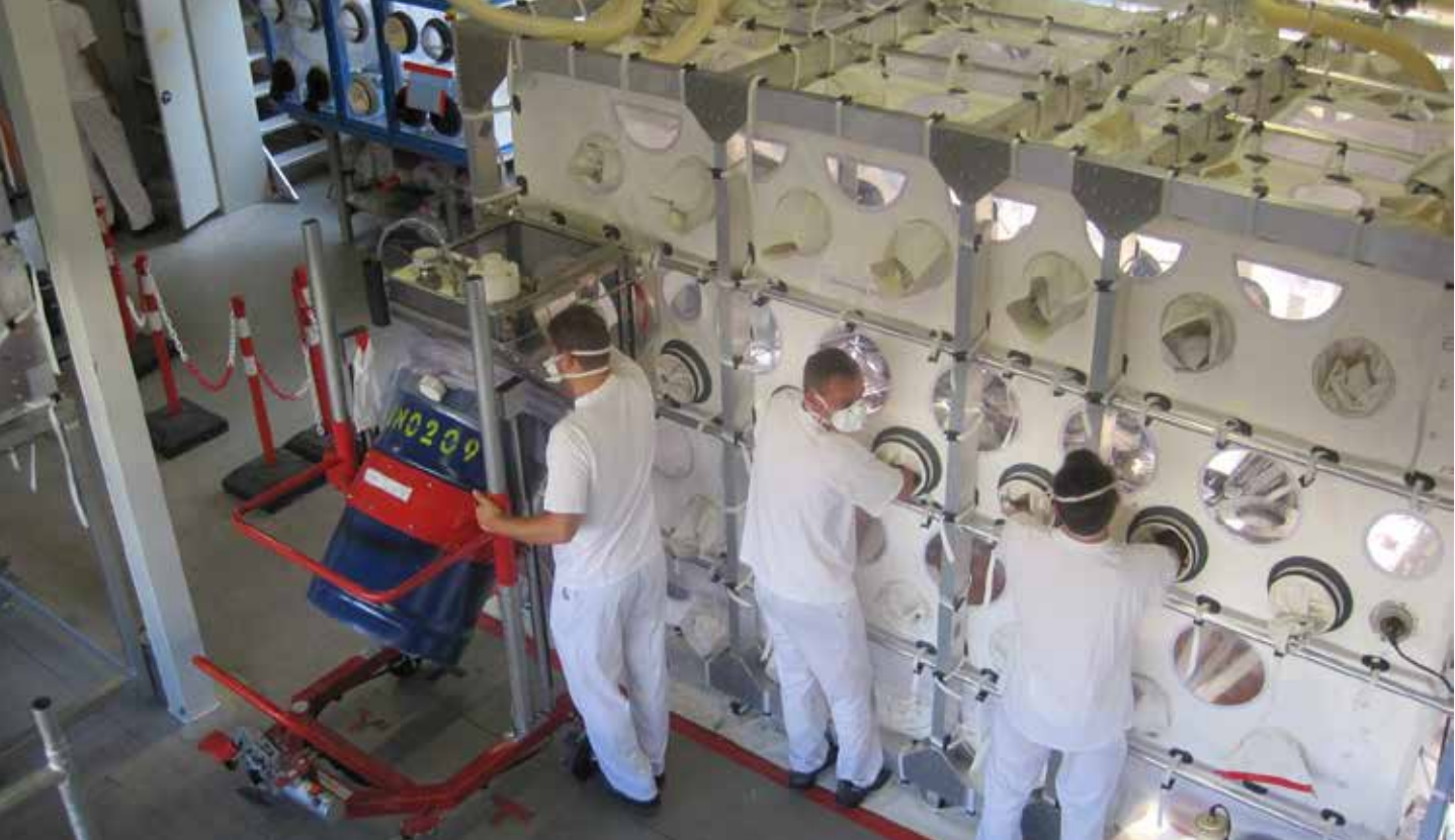
Tous les déchets radioactifs démantelés sur place ont été transportés en toute sûreté dans des fûts fermés vers le site de Belgoprocess à Dessel.
