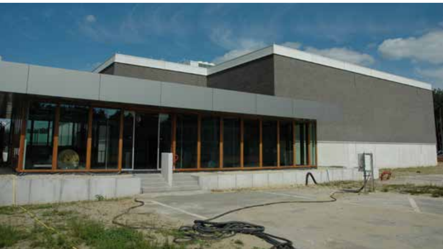
En 2018, Belgoprocess mettra en service un nouveau bâtiment de contrôle.
