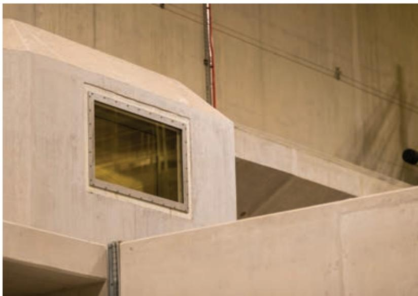
Une fenêtre de verre au plomb donnant sur l'intérieur de l'installation de production de monolithes (IPM).
