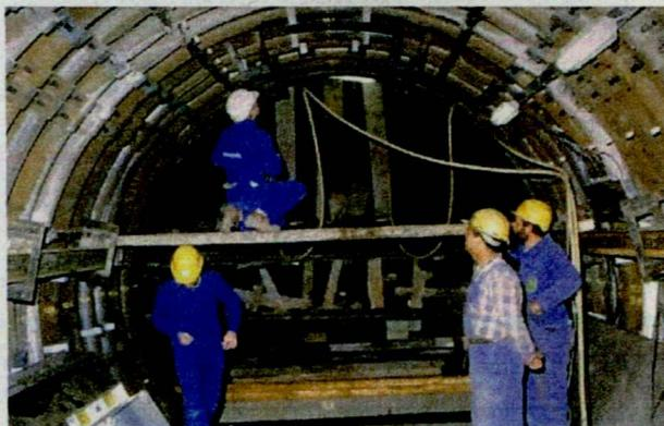
**Figure 3.27** Les trois types de revêtement utilisés jusqu'à présent dans l'installation souterraine : (a) voussoirs en fonte nodulaire (galerie expérimentale HADES) ; (b) claveaux en béton (petite galerie et Test Drift) ; (c) cintres métalliques coulissants (Test Drift, partie ANDRA).
