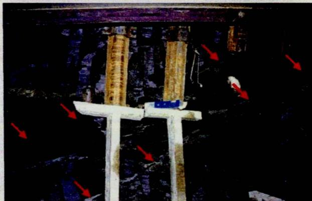
**Figure 3.29** Creusement du deuxième puits. Plan de glissement et fissures observés lors du creusement de l'amorce de la galerie de liaison.
