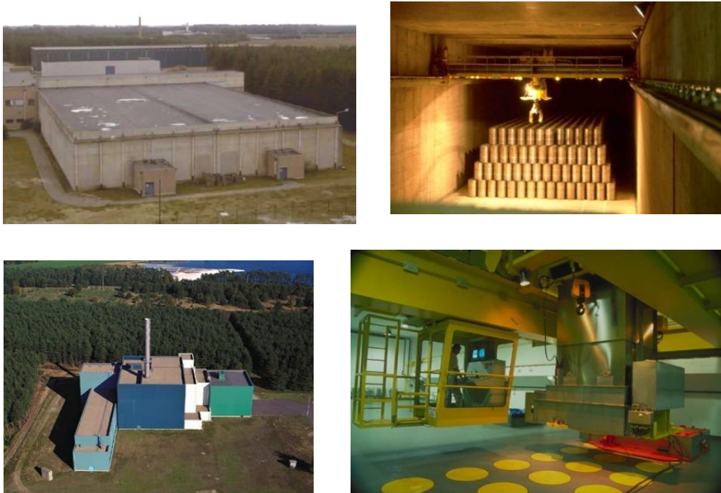
Figure 12 – Entreposage à Dessel. En haut : bâtiment 127 d’entreposage de déchets conditionnés de moyenne activité ; en bas : bâtiment 136, zone-X, d’entreposage des déchets conditionnés de haute activité.
