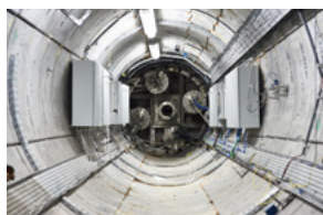
Aperçu de la galerie PRACLAY dans le laboratoire HADES.
