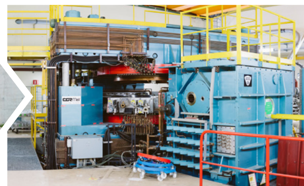
Fin des opérations d'assainissement à Fleurus
