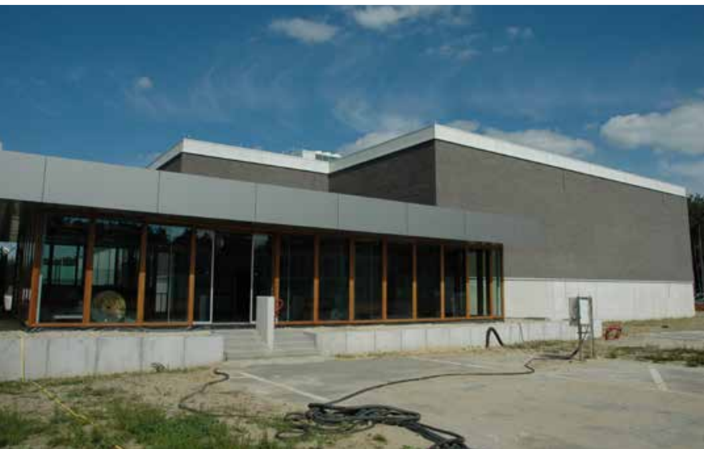
In 2018 neemt Belgoprocess een nieuw controlegebouw in gebruik.
