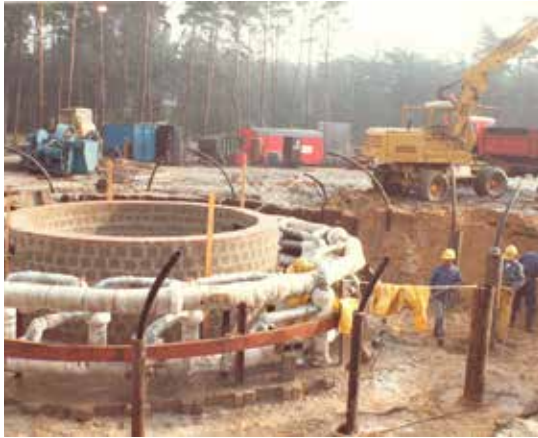
In 1980 ging de bouw van HADES van start.
