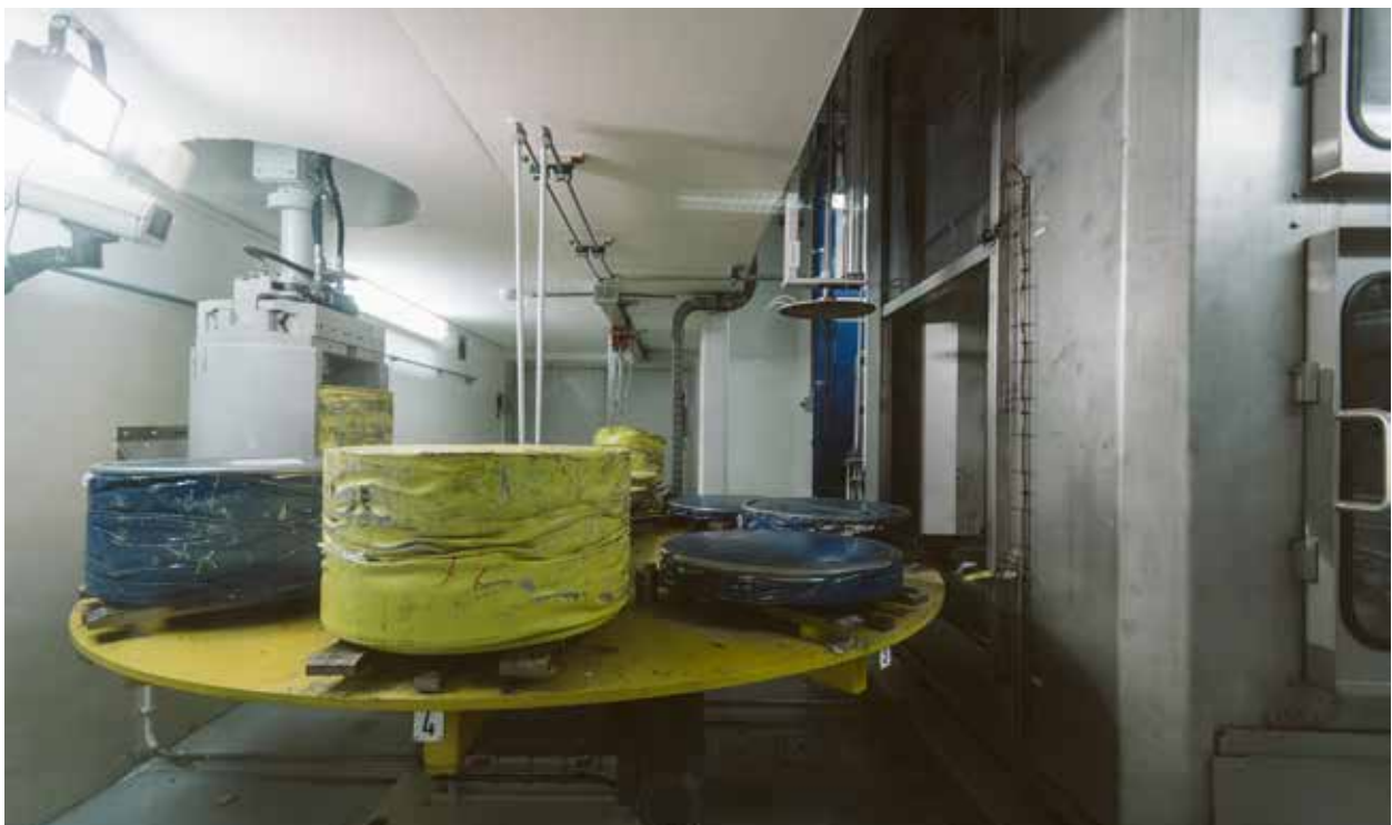
Om het volume te verkleinen, worden de afvalvaten samengeperst.
