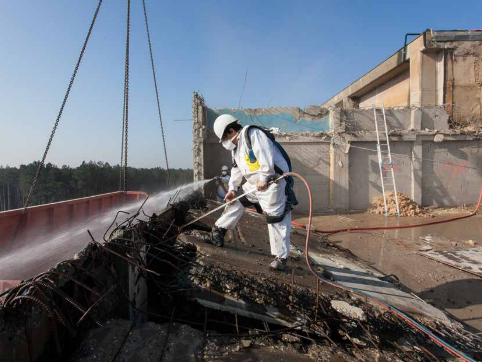
Een deel van de gebouwen van de Eurochemic-fabriek is ondertussen al afgebroken.
