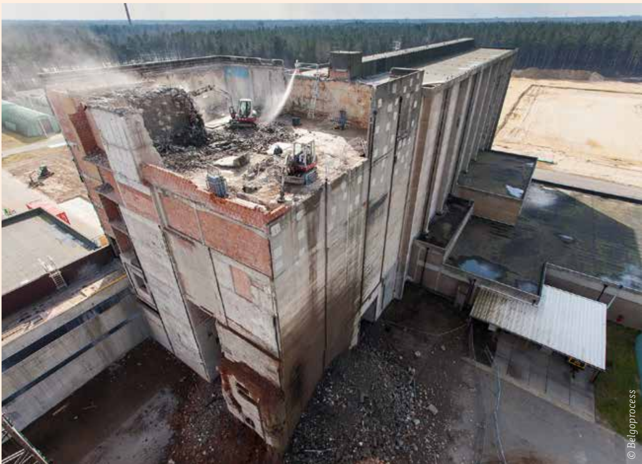
De afbraak van de oude Eurochemiefabriek in Dessel.
