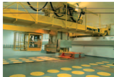
Afval van categorie C, dat gedurende meerdere tientallen jaren warmte afgeeft, wordt door anderhalve meter gewapend beton afgezonderd van de buitenwereld, terwijl de warmte door een krachtig ventilatiesysteem wordt afgevoerd. De containers worden met behulp van een afgeschermd laadmachine gestapeld.
