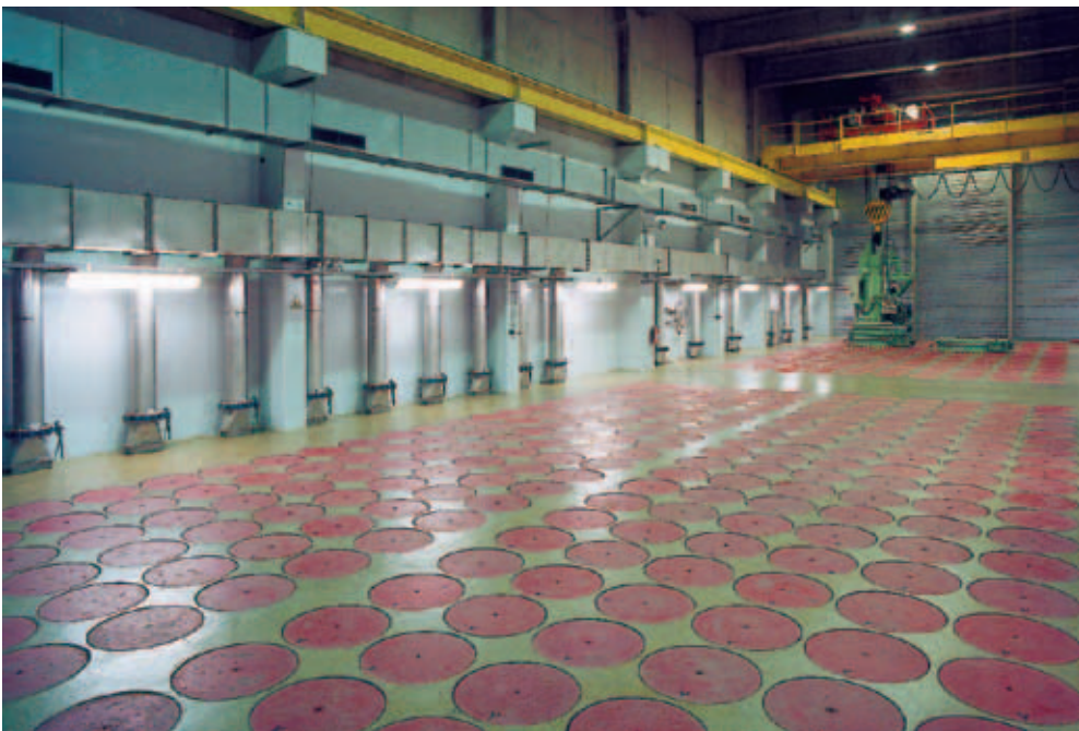
Afval van categorie C, dat gedurende meerdere tientallen jaren warmte afgeeft, wordt door anderhalve meter gewapend beton afgezonderd van de buitenwereld, terwijl de warmte door een krachtig ventilatiesysteem wordt afgevoerd. De containers worden met behulp van een afgeschermd laadmachine gestapeld.
