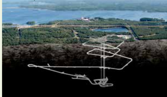
De bouwvergunning voor de geologische bergingsinstallatie in Finland werd begin november toegekend in wereldpremière.
