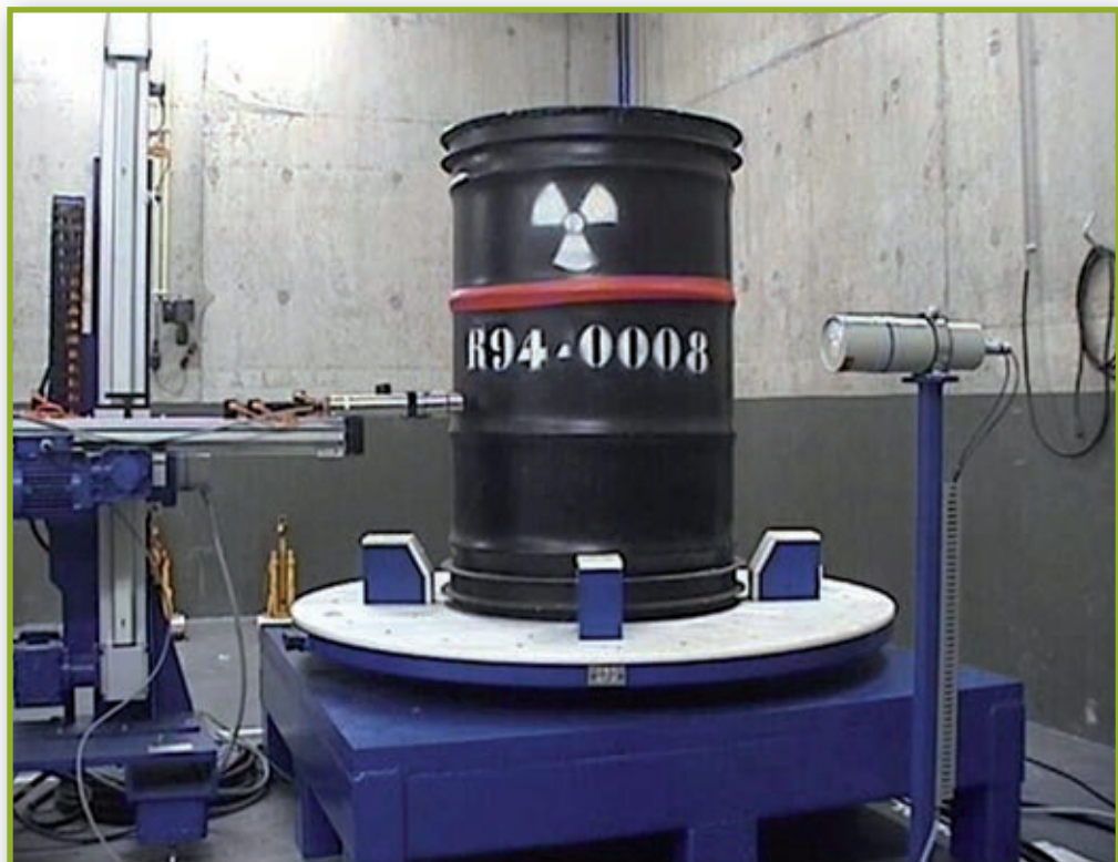
Contrôle par caméra et mesure du débit de dose sur un colis déchets dans le bâtiment 127
