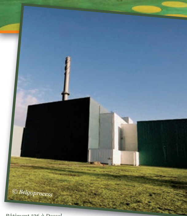
Bâtiment 136 à Dessel
